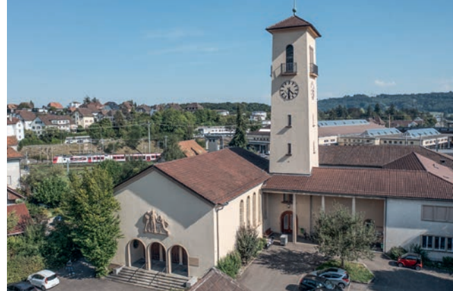
Pour des raisons de rénovation, la Maison St-Paul sera fermée jusqu'en mars 2025. Les activités en cours sont réparties dans les autres maisons de paroisse
