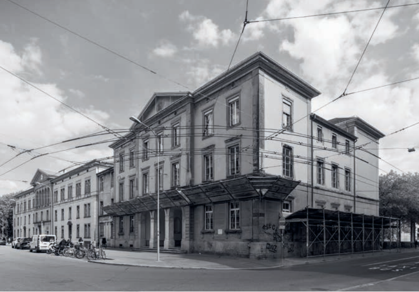
Ecke Dufourstrasse / Gartenstrasse mit Gerüst vor der Sanierung 2020...
