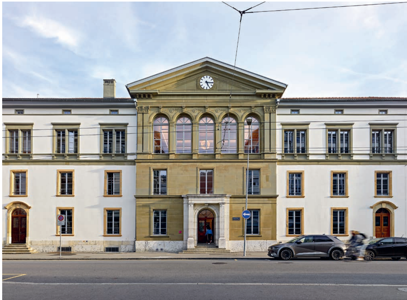
Mittelrisalit mit Haupteingang an der Nordfassade
